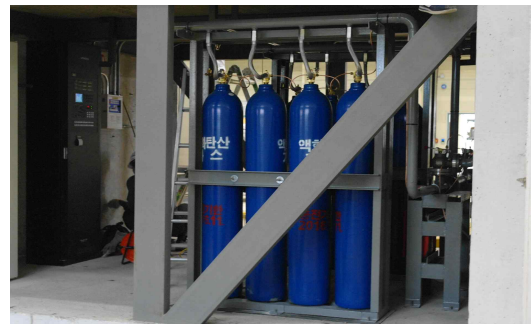
집합형 가스 실린더실 지진발생시 전도방지 설치 예시
